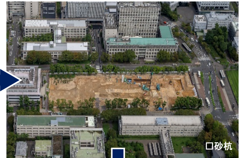
□第2階リフト撤去
