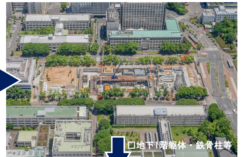
□地下1階耐圧版、地下2階躯体
