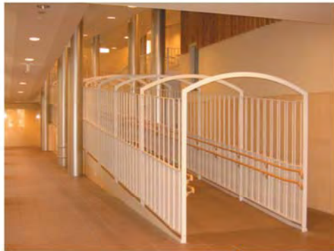
車いす等のための避難用スロープ
