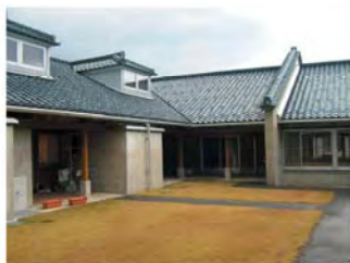
町家風の木造平屋建築の校舎
