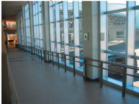
勾配が緩やかでゆとりのあるスロープ
