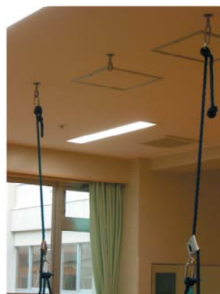
自立活動室の天井には器具を吊すための吊り具がある
