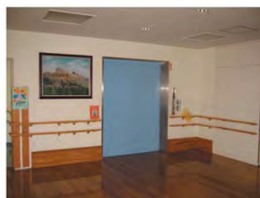
エレベーターの設置。複数の車いす利用者による利用やストレッチャーの利用に対応できる大型のエレベーターとしている
