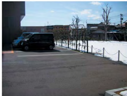
駐車場の積雪対策。地面の下に積雪を防止する温水が通るパイプを敷設している
