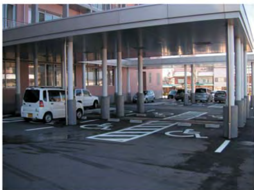
車いす使用者用駐車スペース。十分な駐車スペースを確保するとともに雨天時の乗降に配慮して屋根を設けている
