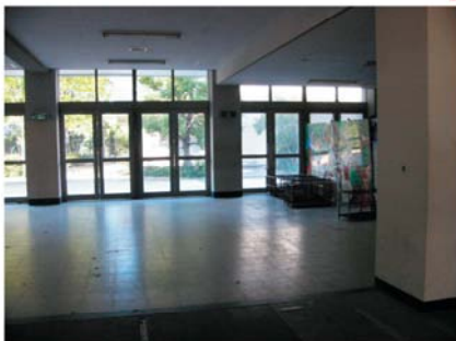
①旧高等学校時代の玄関。校舎玄関を流通サービス科の「バックヤードサービス分野」の接客指導のための実習室に改修した
