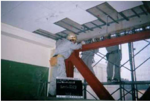
鉄骨ブレース工事
