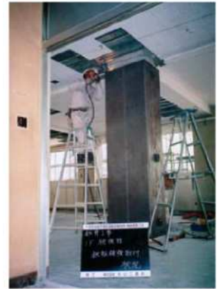
柱鉄板巻補強
