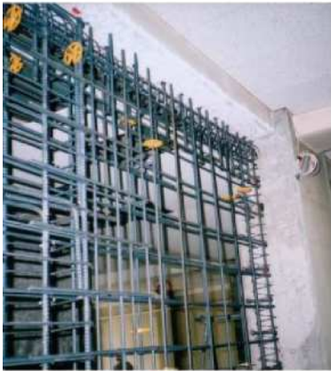
耐震壁の増設工事
