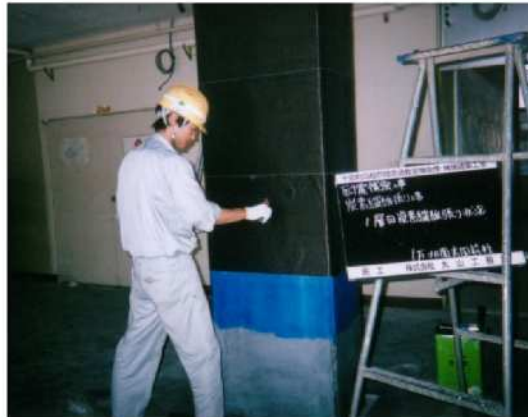
柱炭素繊維巻補強
