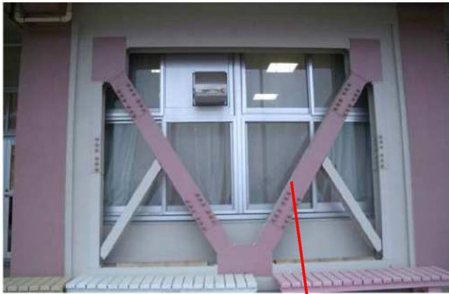
鉄骨ブレース
