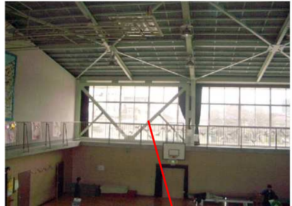
鉄骨ブレース
