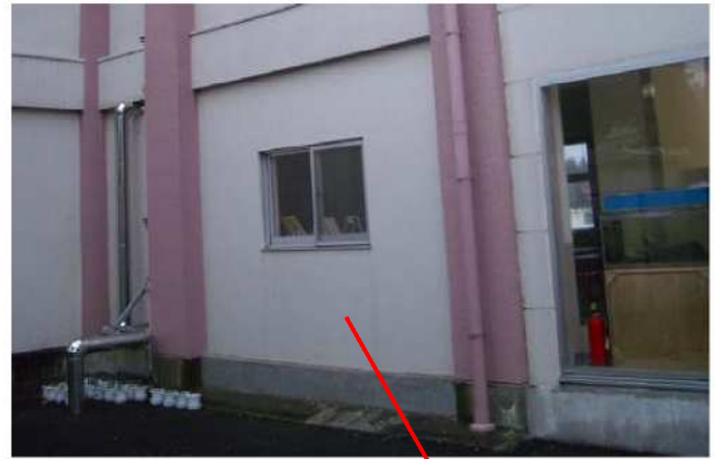
耐震壁の設置
