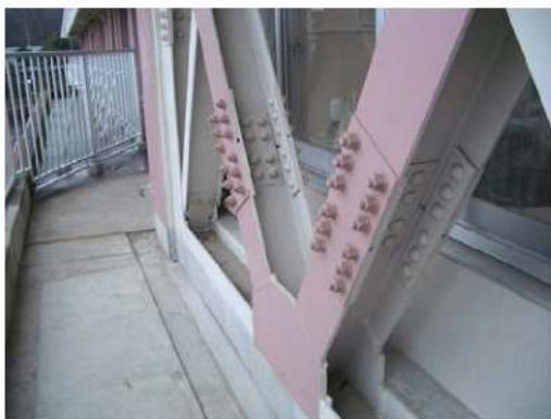
鉄骨ブレース補強詳細写真
