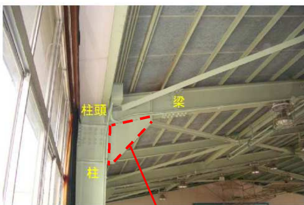
柱、梁仕口部のリブプレートによる補強
