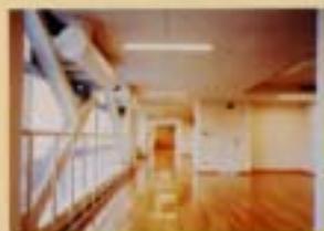
耐震補強された校舎
