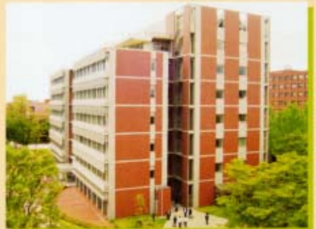
大学院施設の狭隘解消のための総合研究棟の整備
