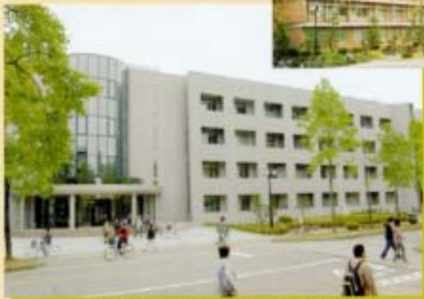
老朽化した施設の改善(右上:改修前)
