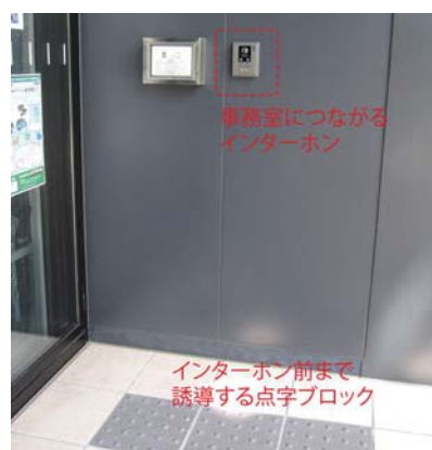
図-2 インターホンまで点字ブロックで誘導している
