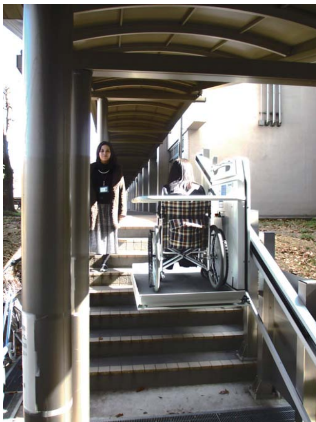
図-2 段差解消機使用例
