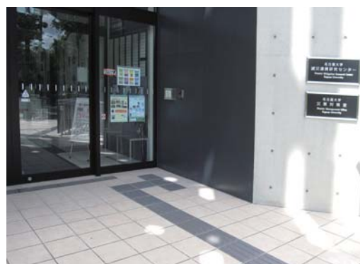
図-1 減災館 点字ブロック敷設状況
