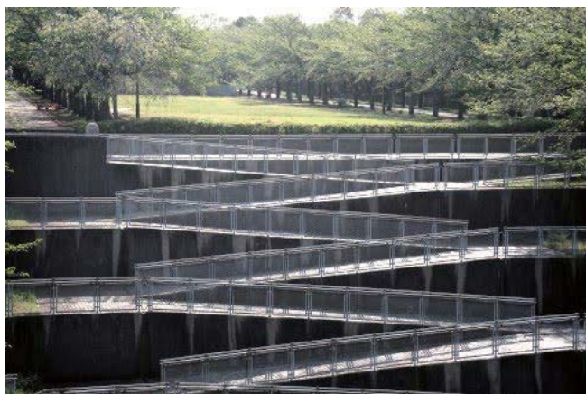
図-1 屋外スロープ
