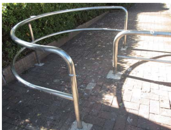
図-2 車いすで通れる柵
