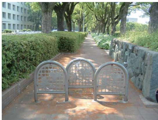
図-1 車いすで通れない柵
