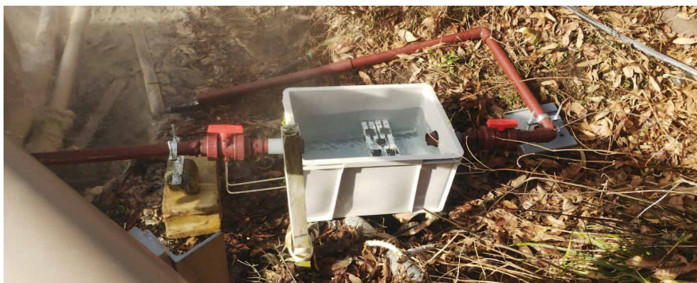
写真2 温泉水を利用した長期浸漬・通水試験の様子
