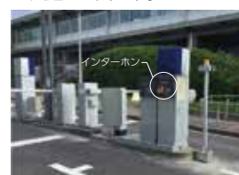
（更新後）インターホンが設置され交通整理員の常駐が不要となった
