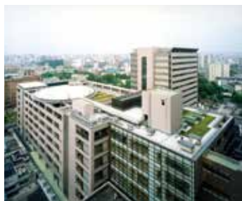
中央診療棟 (2005年建設当時)
