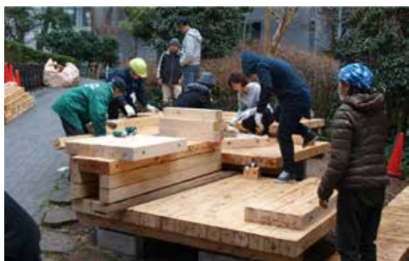
図4 生協南部エリアのベーカリーショップ(上)と生協理系ショップ前で施工中のウッドデッキ(下)
