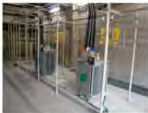
高効率変圧器
