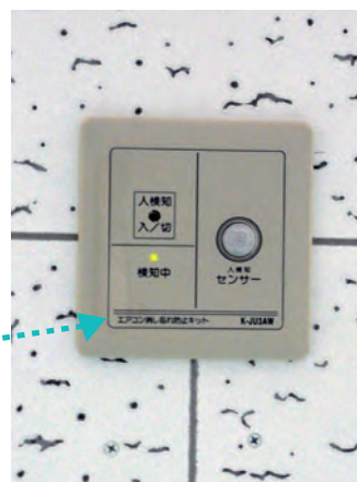
消し忘れ防止キットの拡大写真 一定時間不在のときは空調機が停止します。
