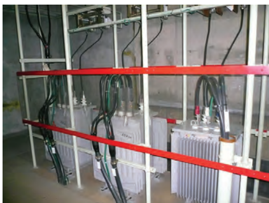
更新前 6.6kV 単相変圧器 100kVA 3台
