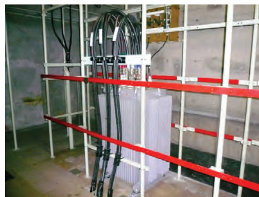
更新後 6.6kV 単相変圧器 300kVA 1台
