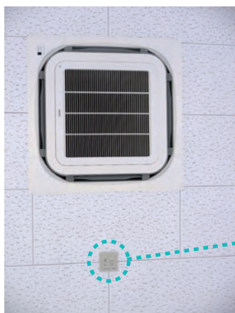
天井埋込型空調機と消し忘れ防止キット
