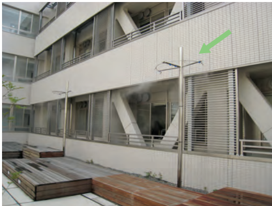
全学教育棟に設置したドライミスト
