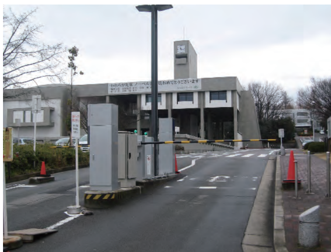
新しくなった入出構ゲート
