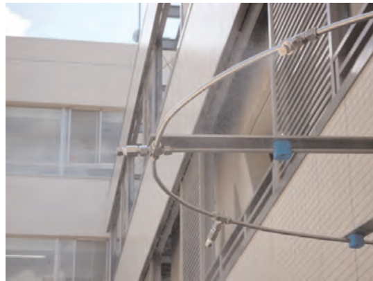
装置の拡大写真 ノズルから微細な霧を吹いて冷やします。
