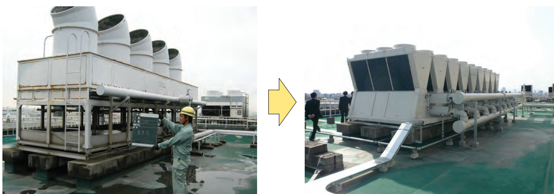
(左：改修前 空冷セパレート型チラー 右：改修後 ヒートポンプチラー) 附属図書館空調設備（屋外機）
