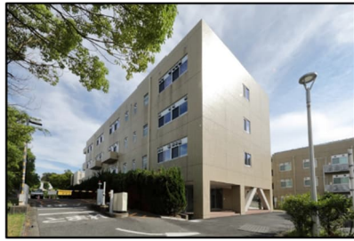
工学部 8 号館北棟
