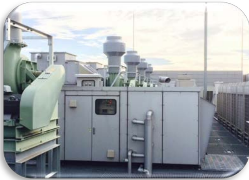
●化学系実験室の給排気設備の例
