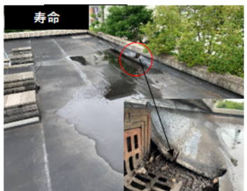
各所で漏水が発生している。(国際交流会館A棟)
