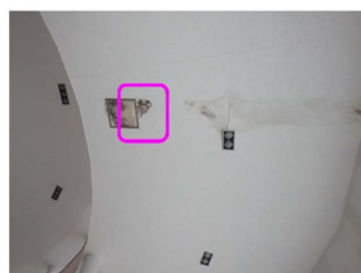
食堂天井部より複数回漏水が発生している。(医学部教育・福利棟)
