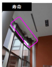
食堂天井部より複数回漏水が発生している。(医学部教育・福利棟)
