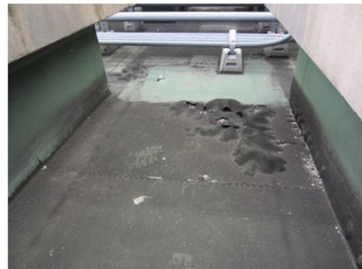
屋上からの漏水による事故 図表-2.90
