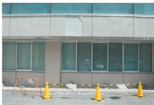
外壁タイルの剥落(平成25年4月)図表-3.9
