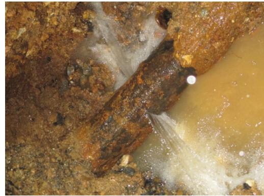
漏水による事故 図表-2.89
