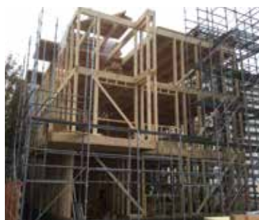
ザインウ正木ビルの建て方の様子
