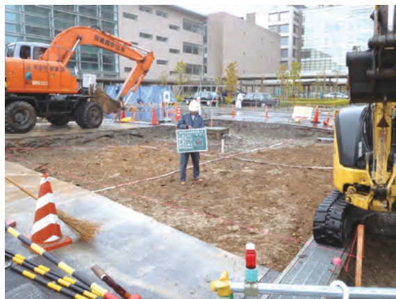
汚染土壌撤去後の状況
