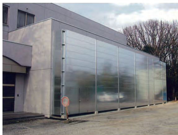
防音パネル設置後
