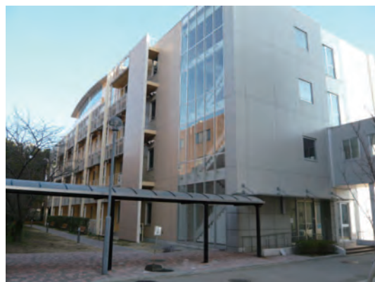
窓ガラスを遮熱性フィルム処置した東館
