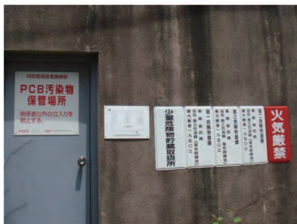
保管場所の外観
