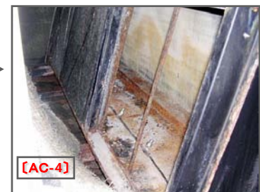
空調機AC-4の内部
