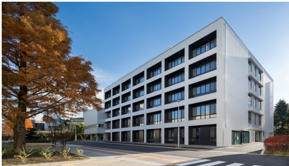
アジア法交流館（延床約5,500㎡） 2015.11竣工
