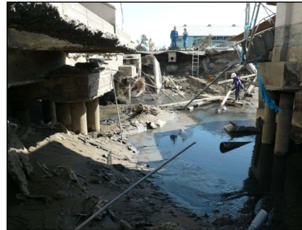
▲庁舎外観(地盤流出)
