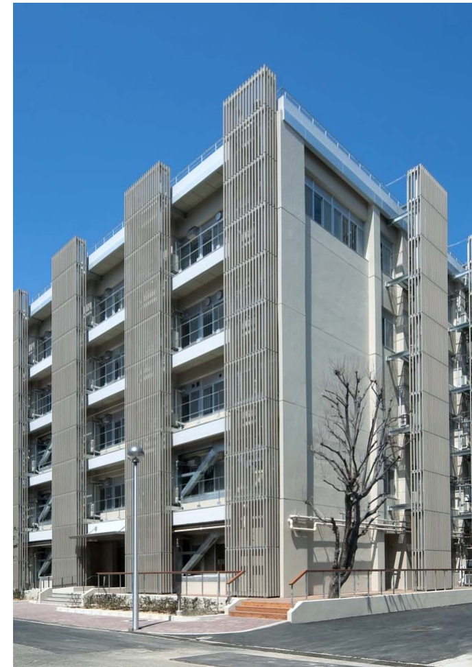
理学部E館：南面（改修）
